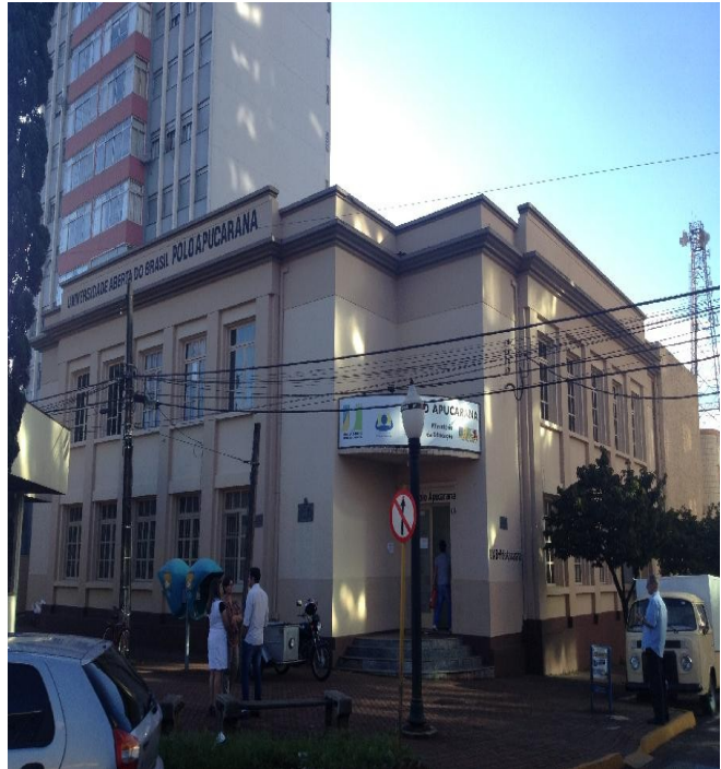
Fachada do Polo
