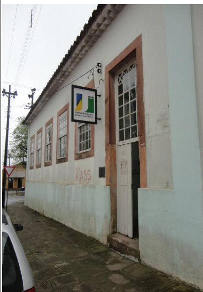
Fachada do prédio
