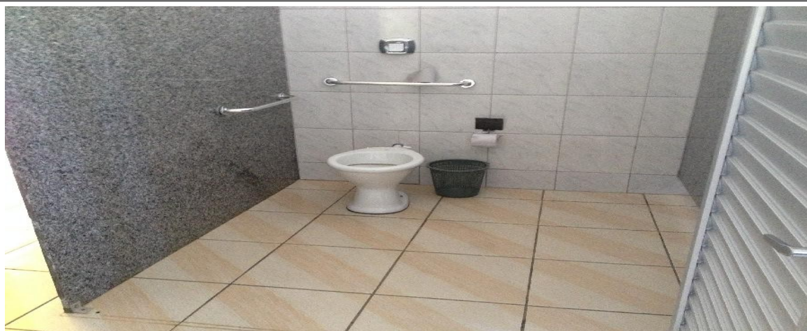
Banheiro com acessibilidade
