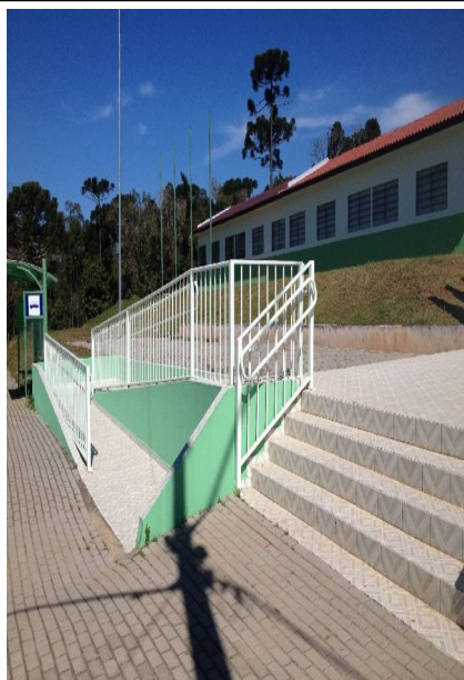
Rampa de acessibilidade na entrada do Polo
