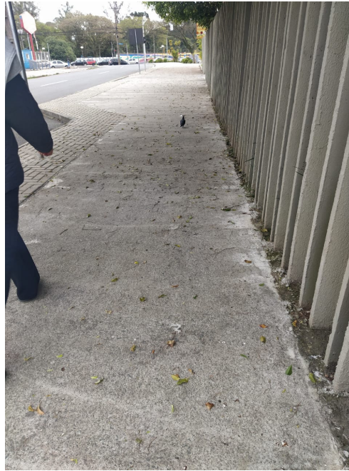
Figura 8. Calçada externa ao redor do prédio.
