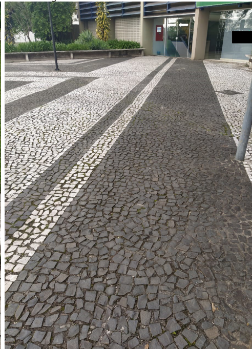
Figura 3. Calçada de acesso à entrada da frente
