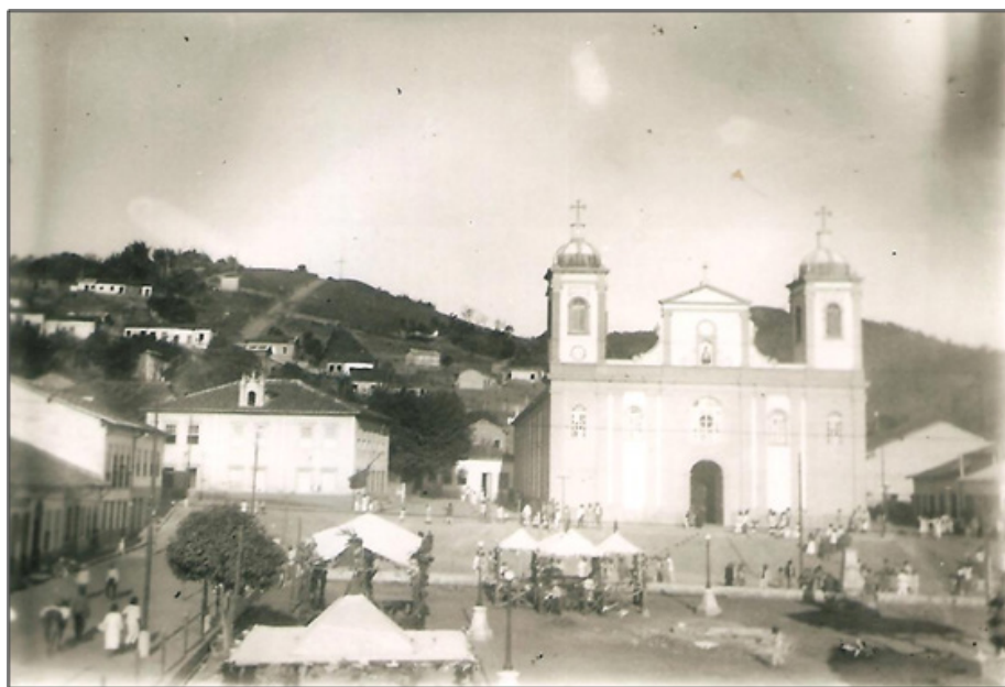
FIGURA 14: IGREJA MATRIZ DE SÃO LUÍS DO PARAITINGA, SP, DESTRUÍDA NUMA ENCHENTE DE 2010.
